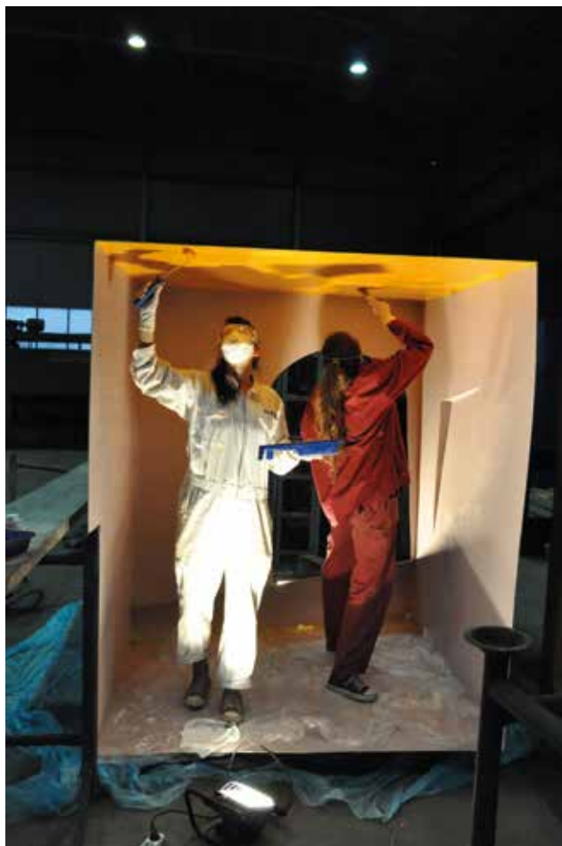
17 Nanošenje završnog premaza (foto: S. M. Sunara, 2014.) Application of final coating (photo: S. M. Sunara, 2014)
