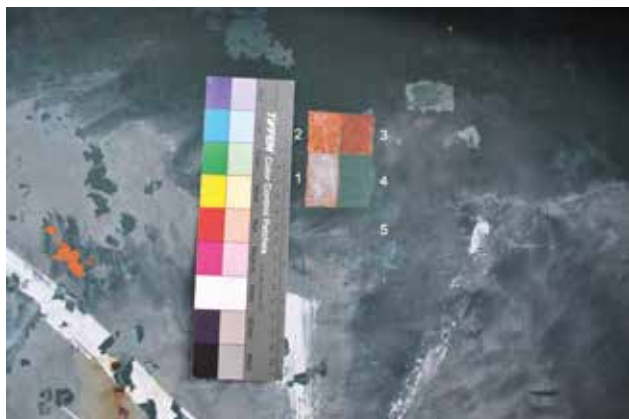
8 Sonda u premaznim slojevima: 1) metalna podloga, 2) temeljni premaz, 3) temeljni premaz, 4) završni premaz, 5) završni premaz (foto: S. M. Sunara, 2014.)
