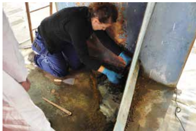
11 Oštećenje u podnici (foto: S. M. Sunara, 2014.) Damage to the bottom plate (photo: S. M. Sunara, 2014)
